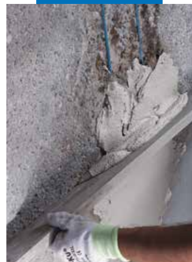
Εξομάλυνση του Planitop Rasa & Ripara με λεία πήξη
