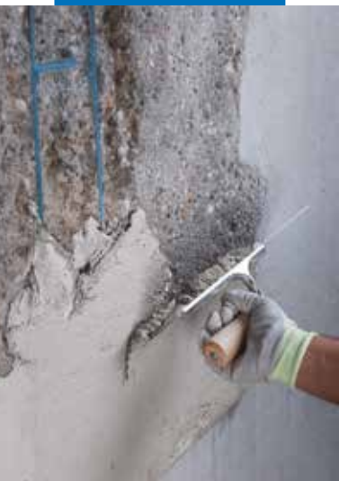
Εφαρμογή Planitop Rasa & Ripara με σπάτουλα
