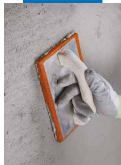
Τρίψιμο του Planitop Rasa & Ripara
