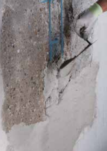
Εφαρμογή Planitop Rasa & Ripara με μυστρί
