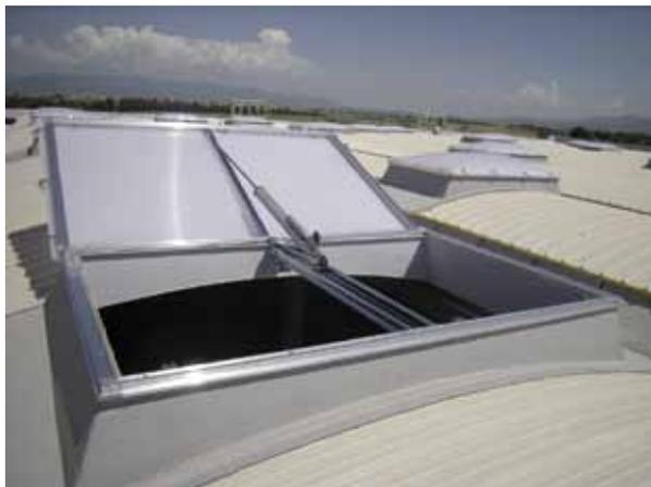
Gli evacuatori naturali di fumo e calore a battente da tetto **SMOKE OUT** prodotti dalla CAODURO® sono **provvisi di marcatura CE, testati e certificati secondo la norma UNI EN 12101-2:2004 da organismo accreditato.**
