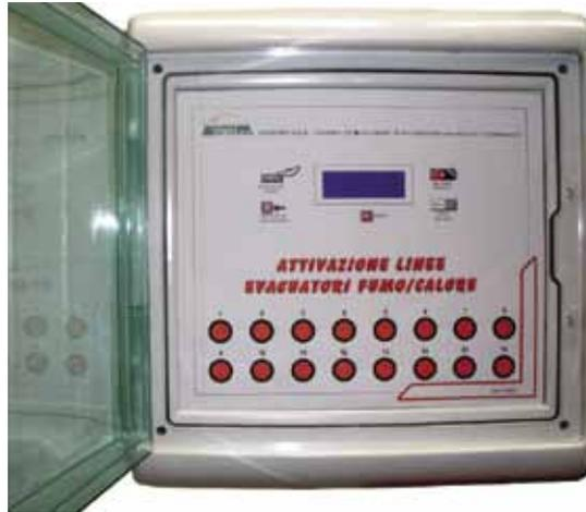
In un unico Box vengono raggruppati fino a 16 pulsanti di emergenza, ognuno dei quali può comandare l'apertura simultanea degli E.N.F.C. appartenenti ad un unico compartimento fino ad un max di 10 per linea. Sul quadro di comando vi sono delle spie di stato, indicanti la presenza della tensione di rete a 220 Volt; batterie tampone scariche; pulsante di reset in caso di intervento sulla centrale. Le stesse informazioni si possono leggere in tempo reale su un display luminoso.
